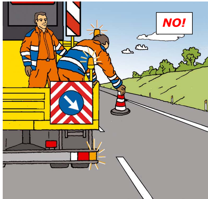
Figura 60 – Posizionamento dei coni o defleco: comportamento scorretto
